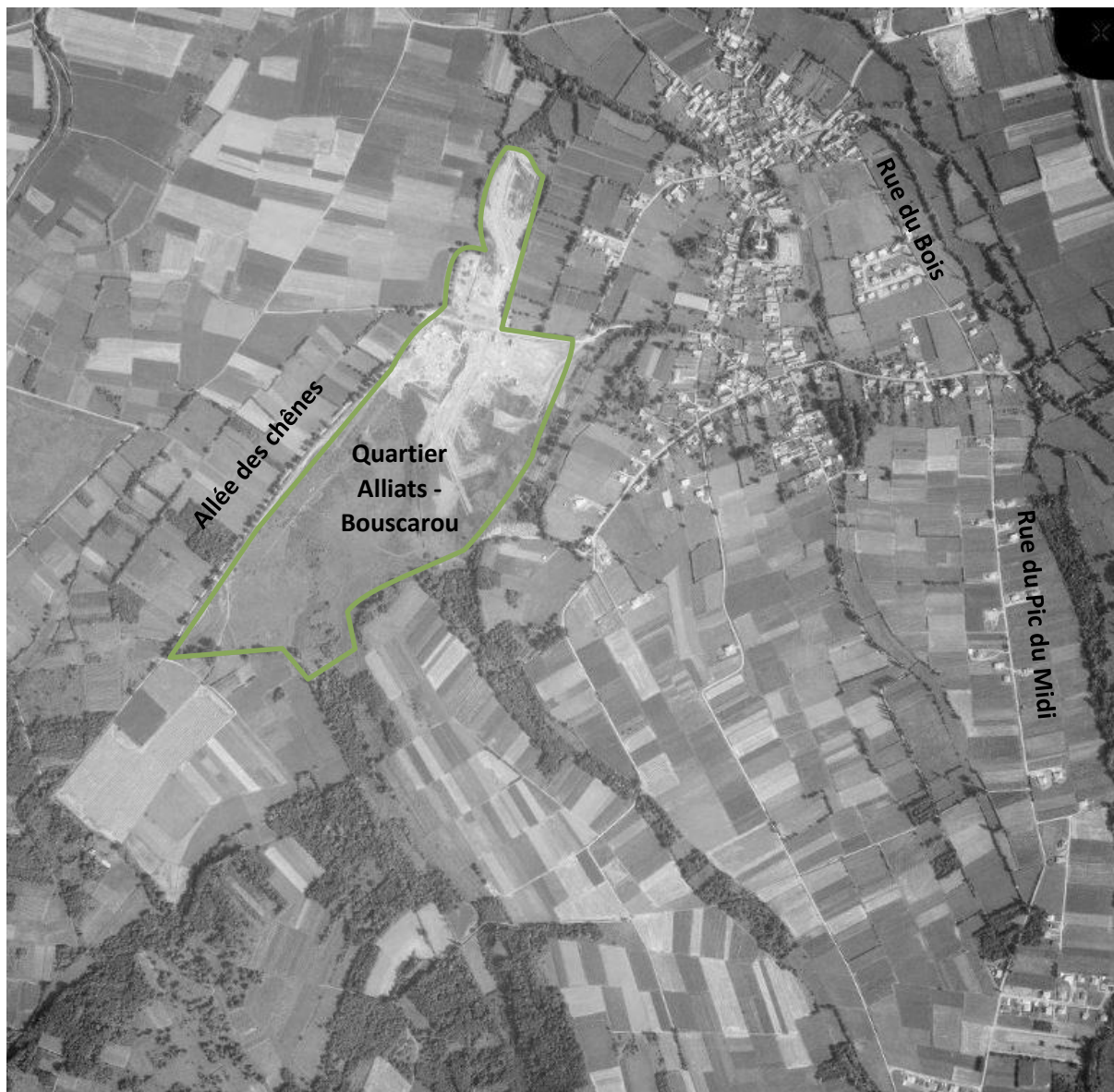
Figure 22 - Photo aérienne du bourg et du quartier Alliats / Bouscarou (1971) 9
